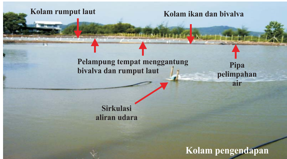
Gbr. 39. Sistem treatment buangan berintegrasi dengan teknologi fisik dan biologi.
