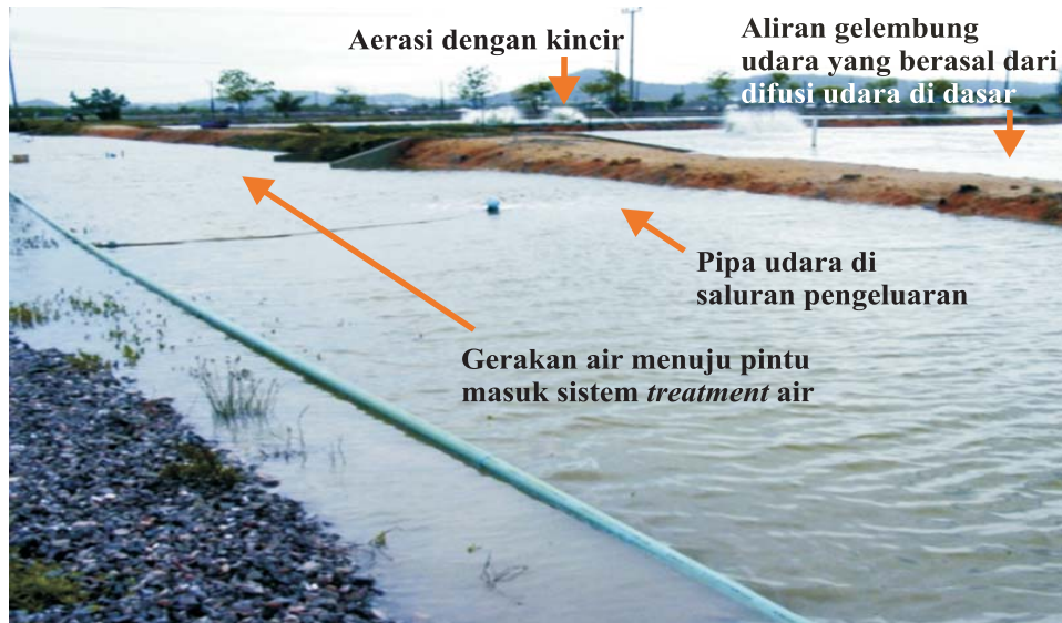
Gbr. 28. Aerasi dan sistim sirkulasi di saluran pembuangan .
